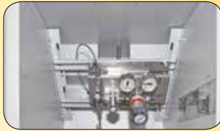
Удобные инсталляционные направляющие для установки газораспределительной фурнитуры*
