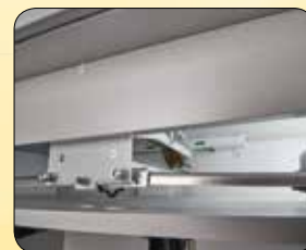
Двери со специальной блокировочной системой, удерживающей их открытыми в любом положении и обеспечивающей автоматическое закрывание в случае пожара
